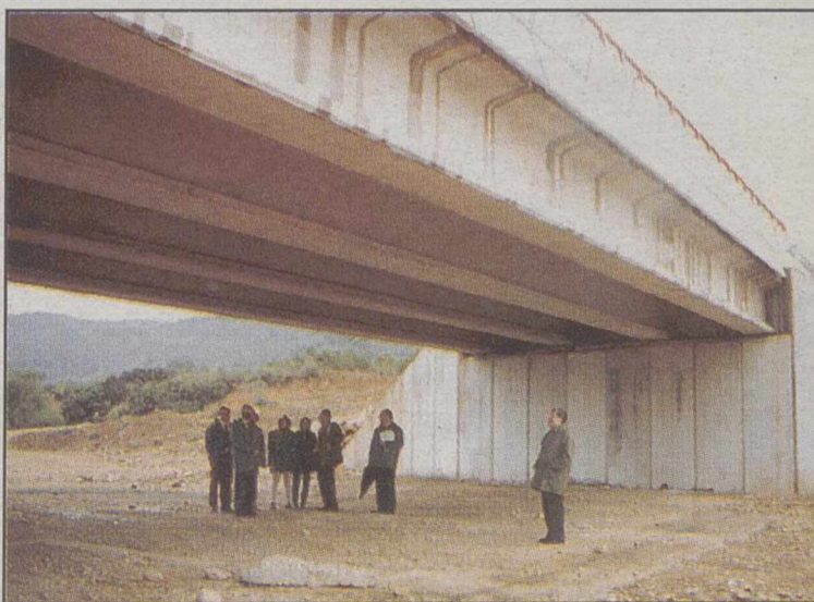
La primera fase de las obras del puente de Híjar ya ha terminado. JOSE LUIS
