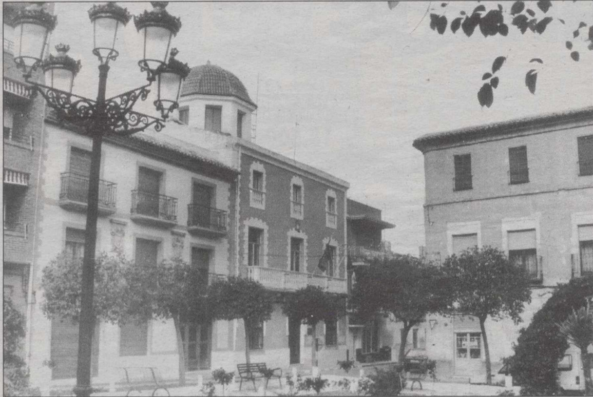
Algunas de las anomalías detectadas están siendo corregidas y otras por el contrario siguen estando.
