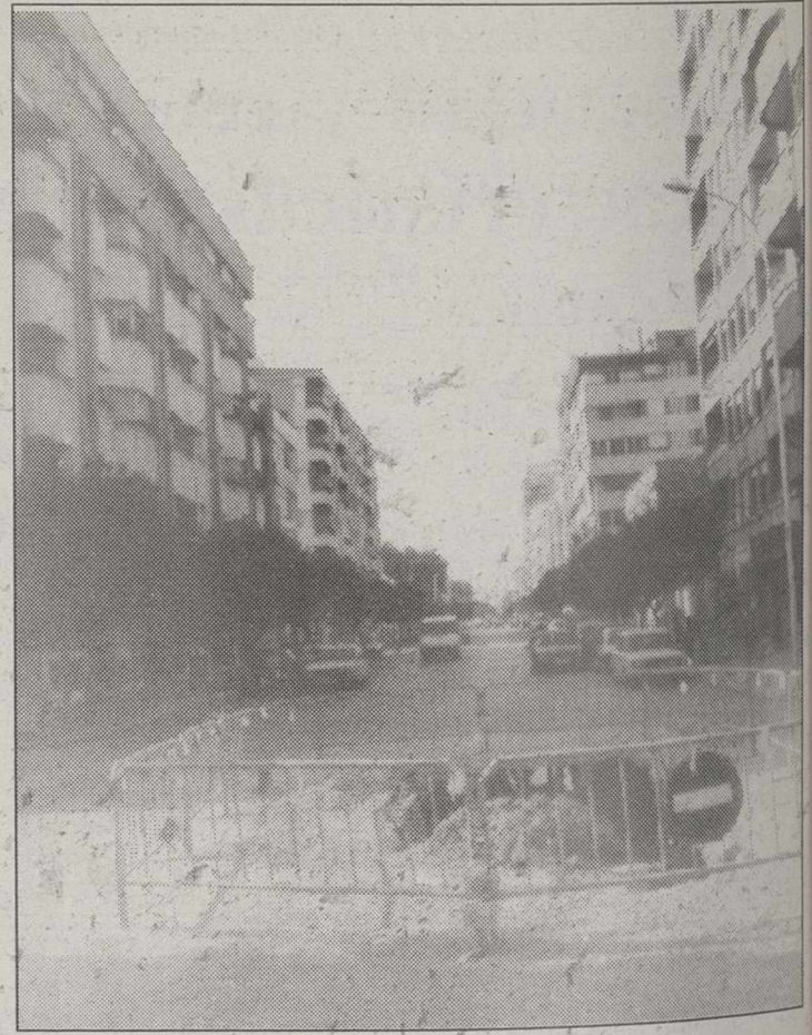
Las obras están causando numerosas molestias a los vecinos.
