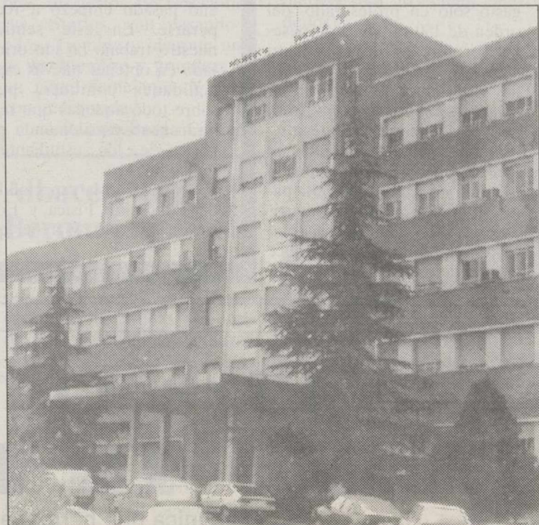
Antigua Residencia Sanitaria.
