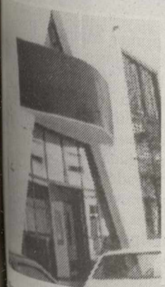
Nuevo centro municipal.
