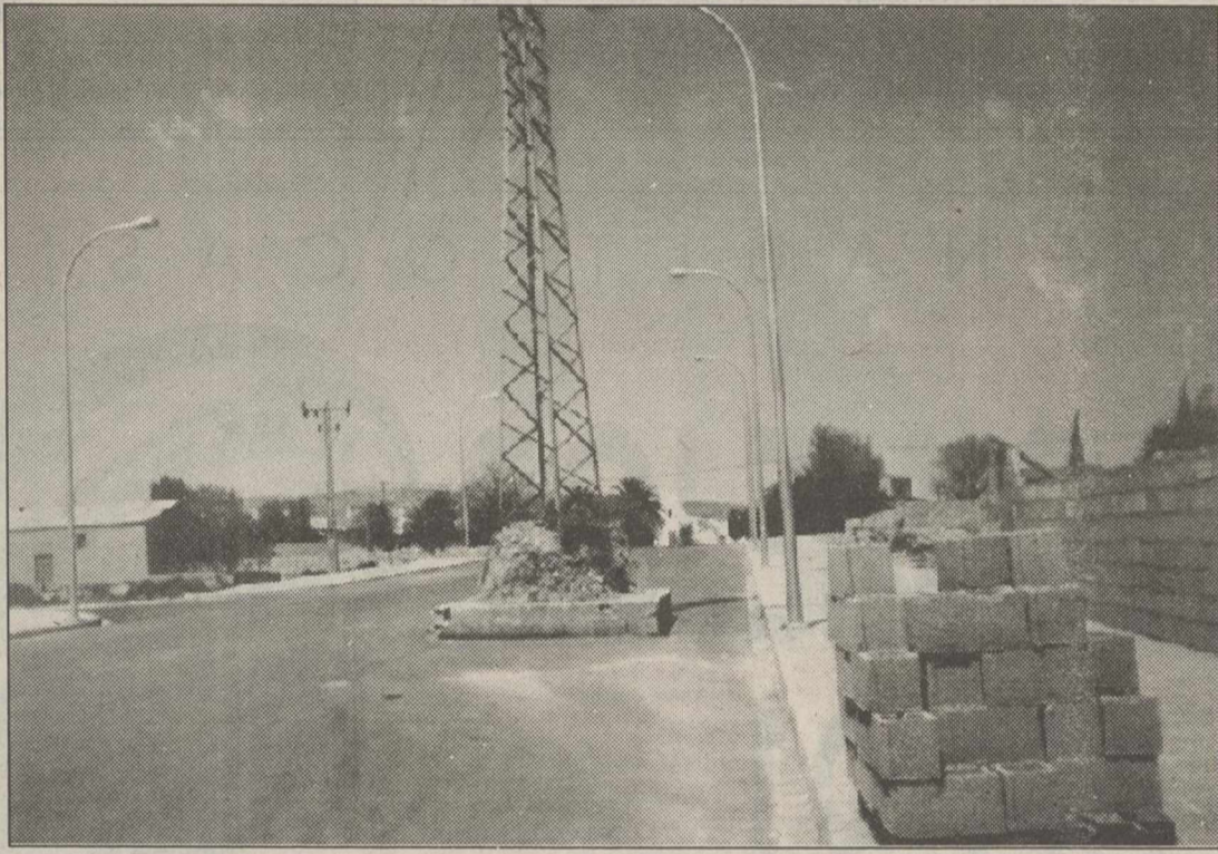
En la foto se puede comprobar la inusual colocación de la torre en medio de la calzada.
