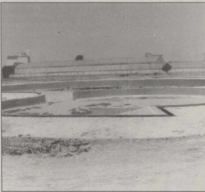
Adiós a la famosa piscina cubierta del Paseo de la Cuba.
