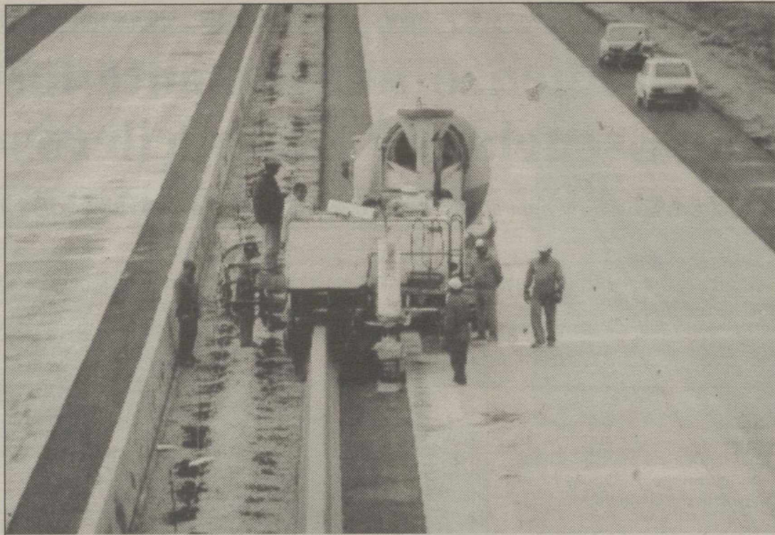
Castilla-La Mancha será, después de Andalucía, la Comunidad en que se construirán más kilómetros de autovías.
