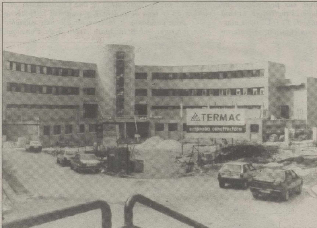
El edificio, que acogerá el Instituto nº 6 y la Escuela de Idiomas, tiene problemas de un acceso fácil por su peculiar ubicación.
