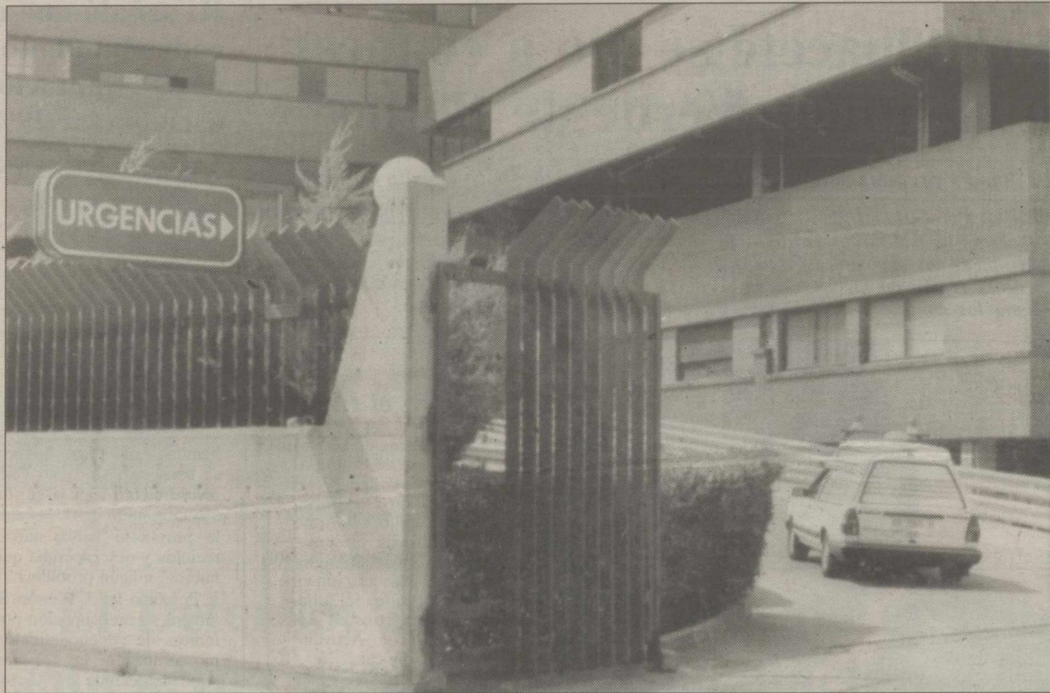
El colectivo de sanitarios está a la espera de la contestación del Defensor del Pueblo.
