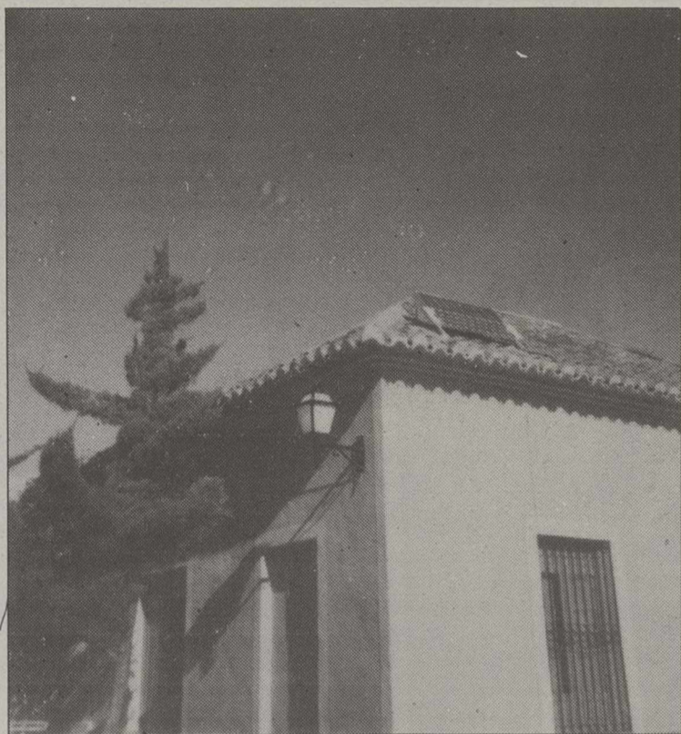
Placas solares en el Cementerio.
