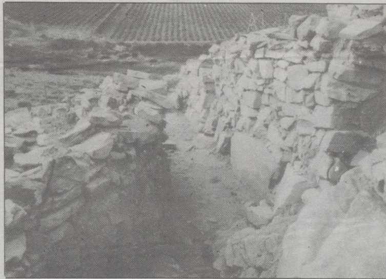
Este año se termina la primera fase de trabajos.
