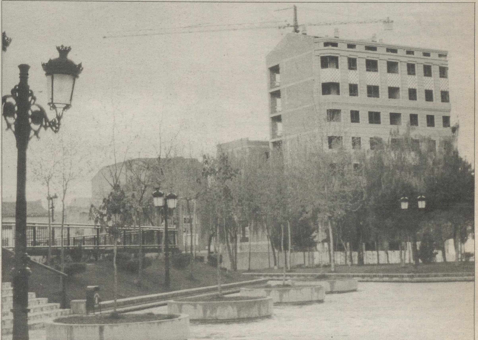
La falta de licencias para instalar grúas, motivo para denegar el boletín de enganche al suministro eléctrico, con la consiguiente paralización de las obras.
