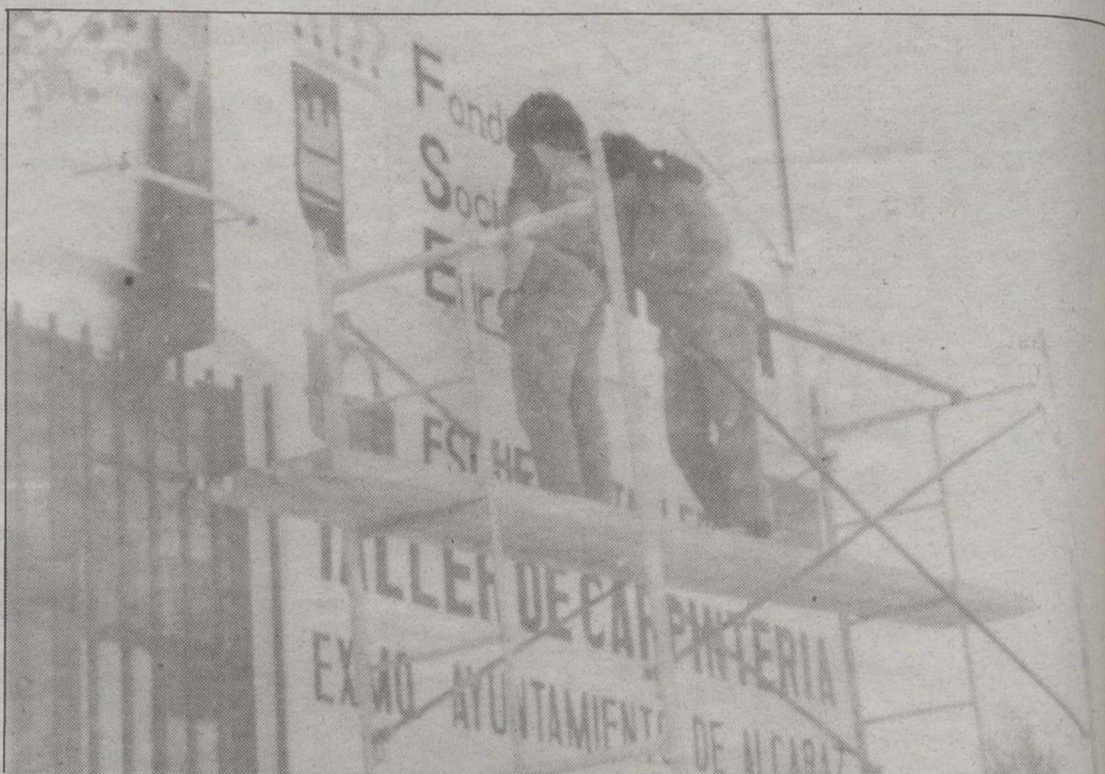
Los alumnos de la Escuela-Taller aprenden la teoría y práctica de la construcción y rehabilitación de edificios históricos
