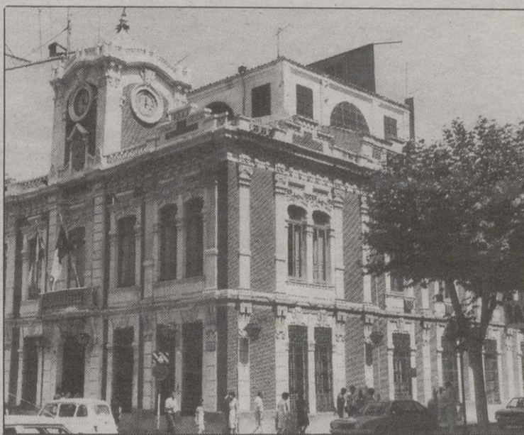
Las obras del viejo Ayuntamiento, sin ayuda de la CEE.
