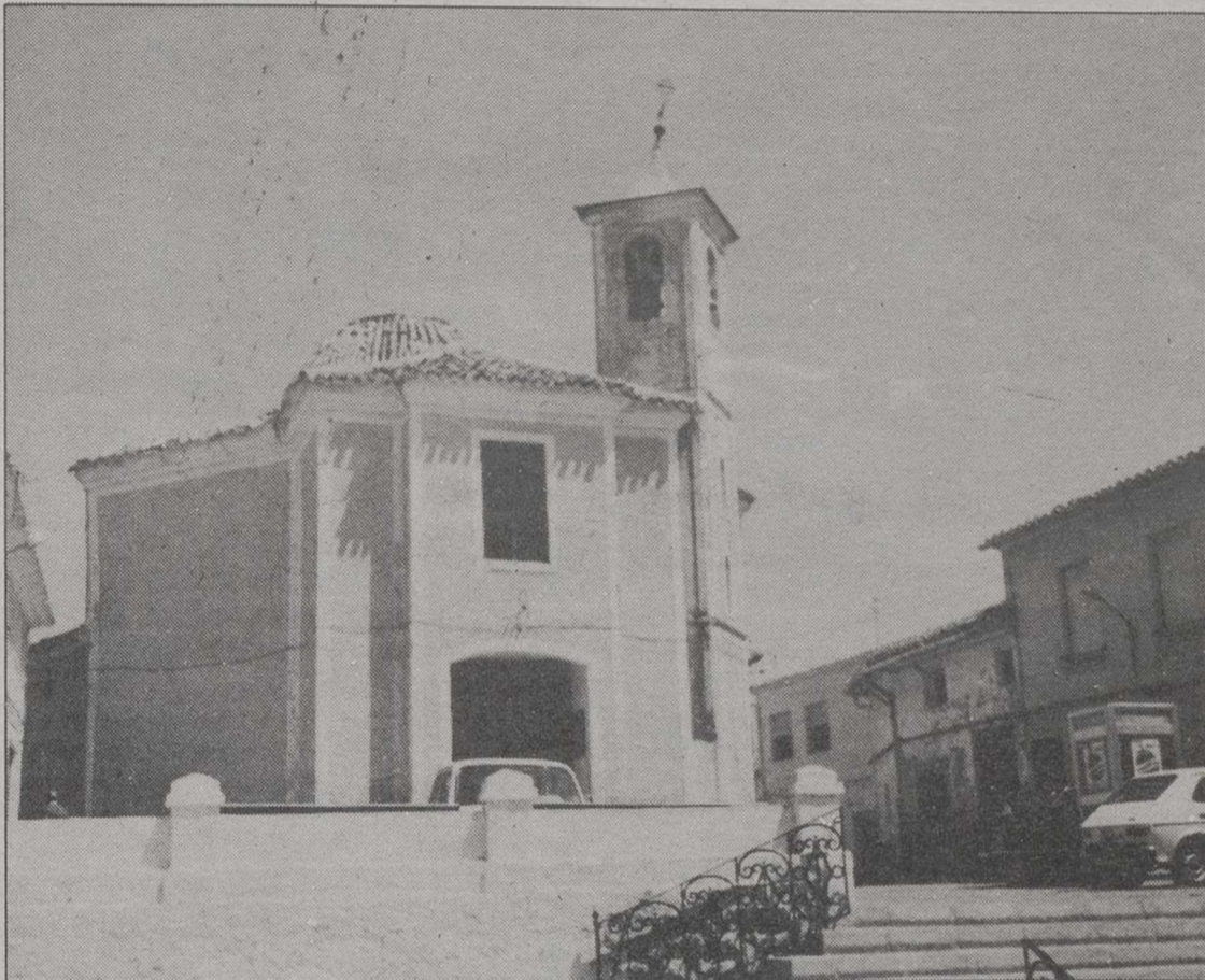
La iglesia de San Roque, que da nombre al barrio, se encuentra en un estado calamitoso.
