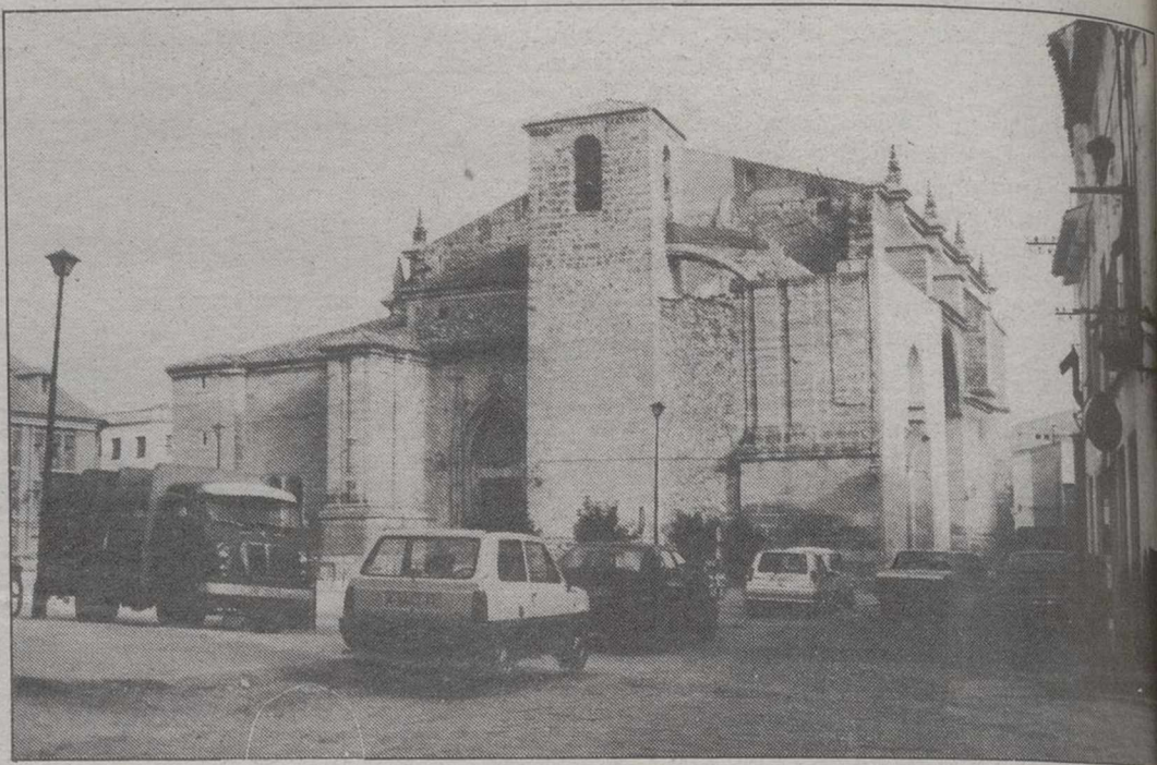
La Escuela-Taller finalizará la iglesia de San Blas, único monumento con que cuenta la ciudad.
