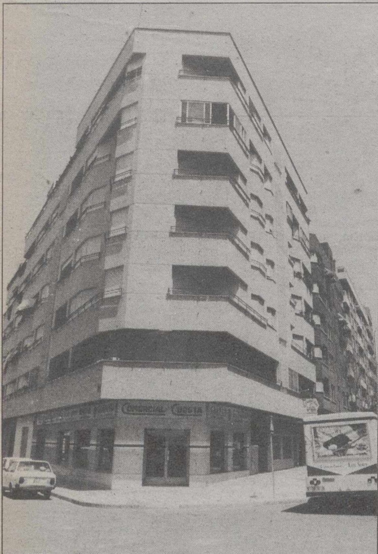
Este es la fachada de la vivienda desde la que se arrojó la vecina de Albacete
