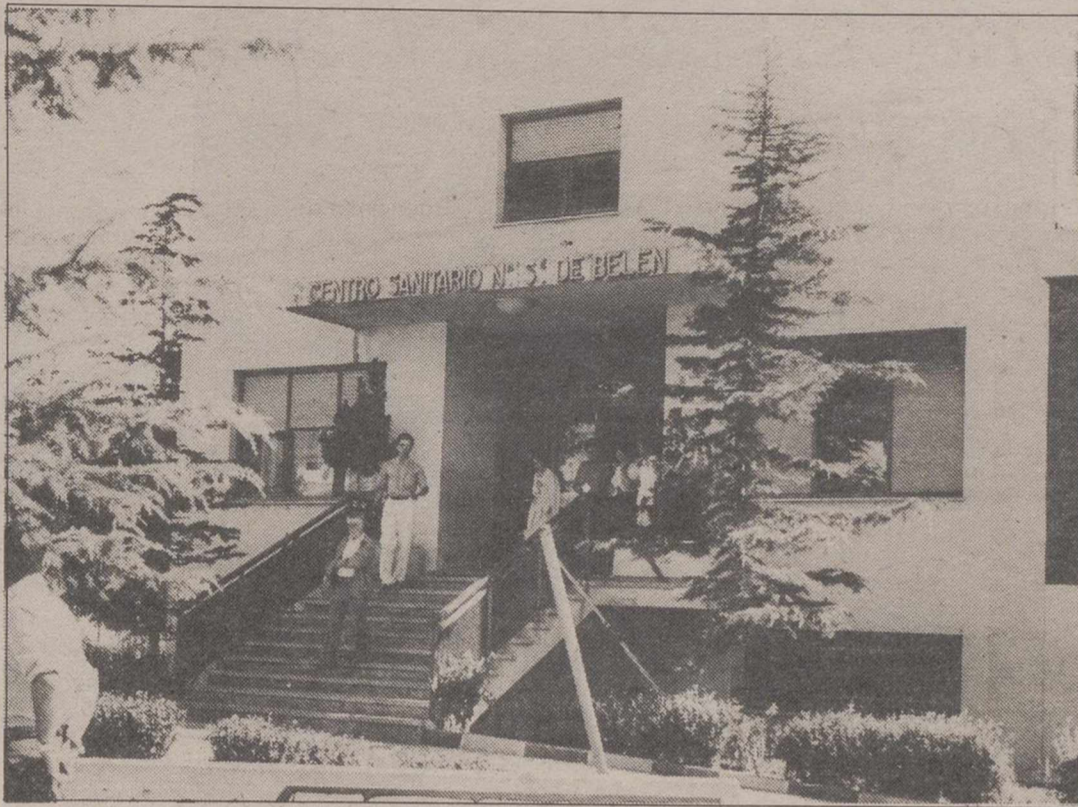
Fuertes críticas en torno a las deficiencias del Centro de Salud
