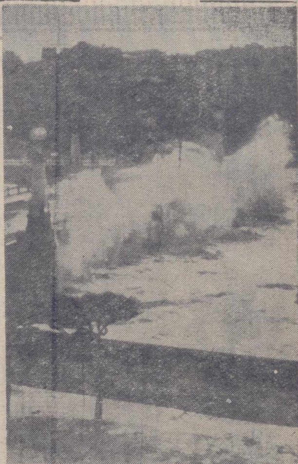
SAN SEBASTIAN.—La pleamar ha producido destrozos en el Paseo Nuevo, donde fueron arrancados algunos bancos y barandillas y destrozados algunos tramos de la calzada. Las aguas saltaron por el nuevo muro, produciendo inundaciones. En la fotografía, las olas arremeten con gran violencia sobre la ciudad. (Telefoto CIFRA)
