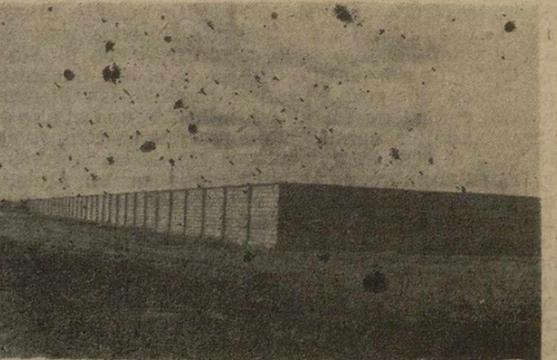
La parte posterior del recinto deportivo ya se ha vallado, con una cerca de tres metros, con piezas prefabricadas de hormigón, lo que permite mantener un ritmo acelerado.
