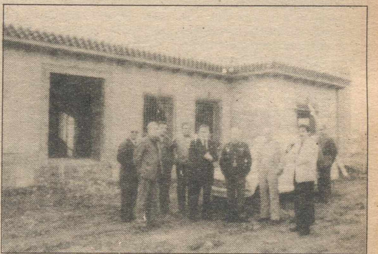
Diferentes etapas de la construcción del puesto de la Cruz Roja en Villarrobledo
