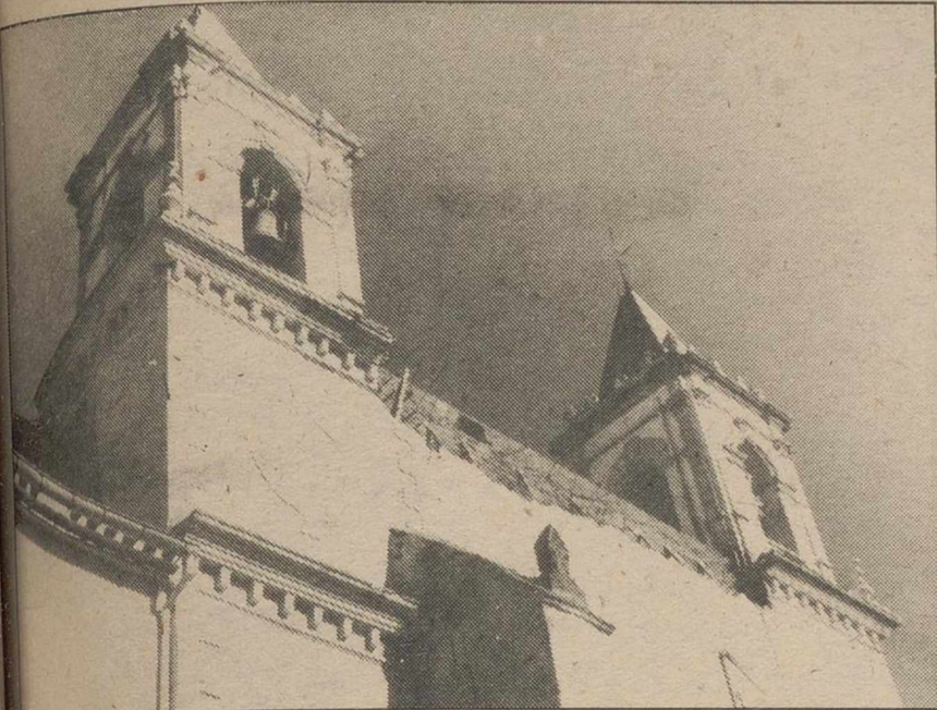
La estructura de toda la cubierta ha sido reforzada con vigas de hierro.
