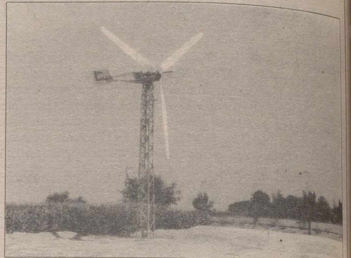
El generador de "La Tiesas" tiene una altura de catorce metros.
