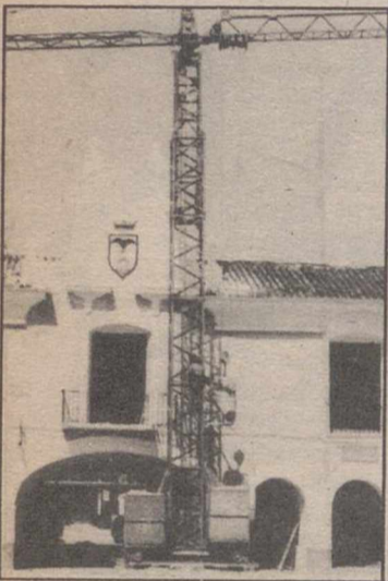
Las obras en el pabellón han empezado, con el despliegue de medios que muestra la fotografía; veremos si es posible ultimarlas antes del 7 de septiembre.
