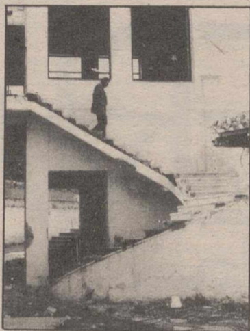
También las escaleras de caracol laterales de acceso al pabellón serán restauradas; José Jerez desciende por una de ellas, a la que ya ha sido arrancada para su recuperación en la medida de lo posible la barandilla de piedra.
