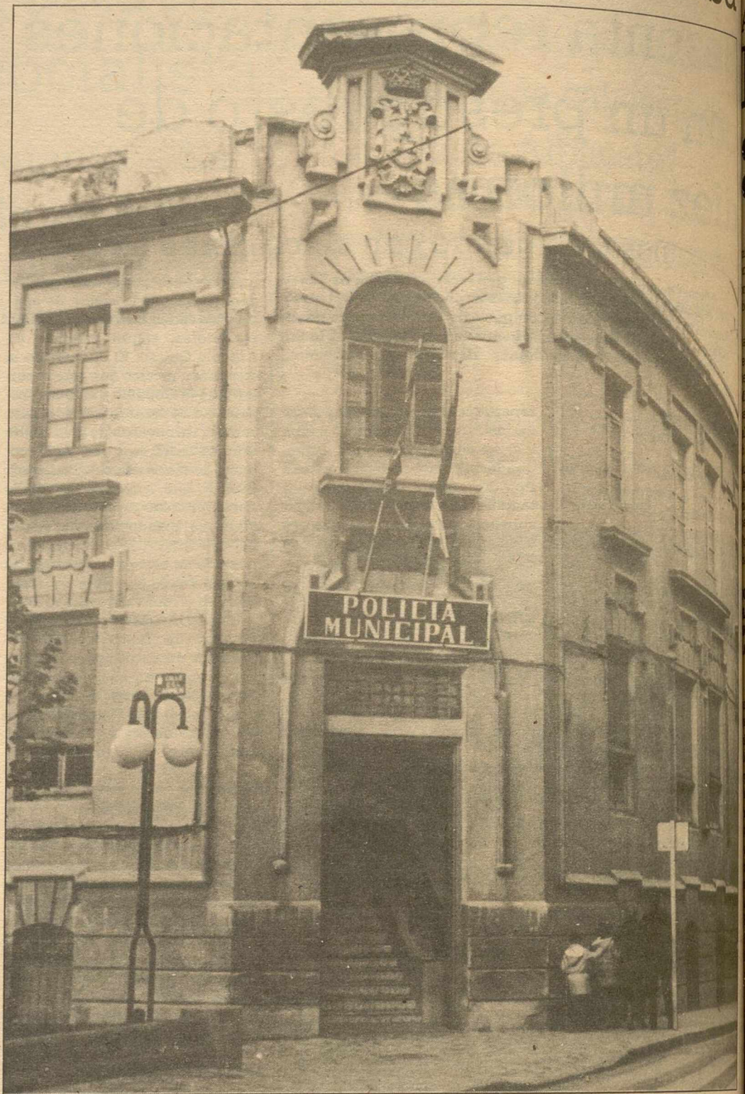
Muy pronto, este edificio será derruido para dejar espacio al que será nuevo Ayuntamiento.
