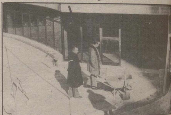
Parte posterior de la "Casa Hortelana", en reconstrucción.
