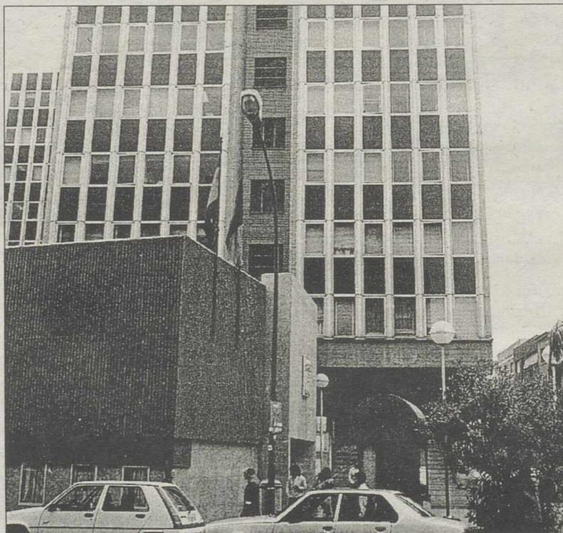
Edificio de Servicios Múltiples, de Ciudad Real.
