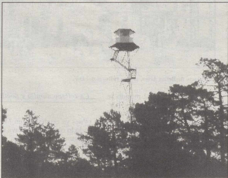
La vigilancia es fundamental para la detección de los incendios.
