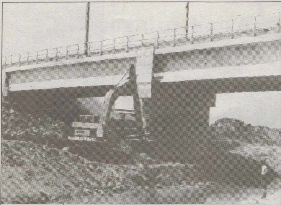
Las máquinas continúan sus trabajos en el Jabalón.
