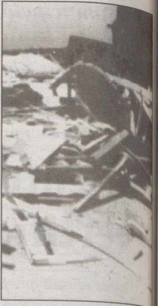
Destrozos en las viviendas.
