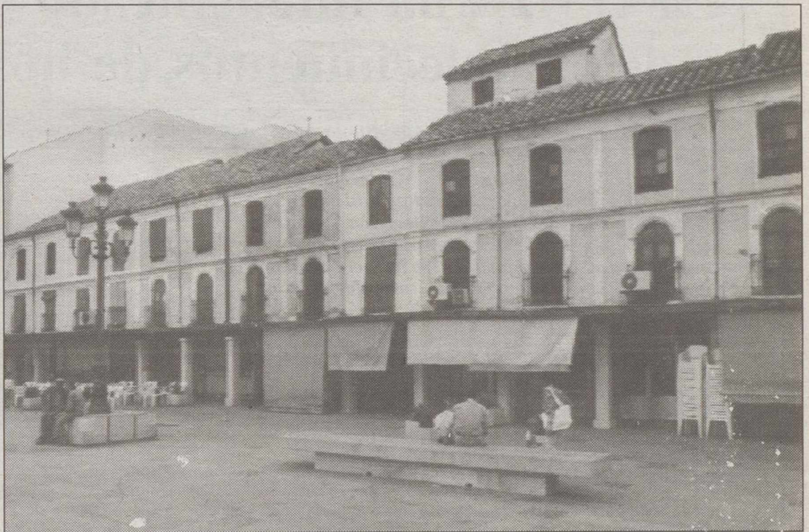
¿Qué pasará cuando haya que construir todo lo que se ve en la foto?
