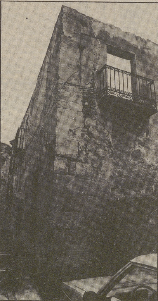
Muchas de las casas antiguas conservan sólo los muros exteriores
