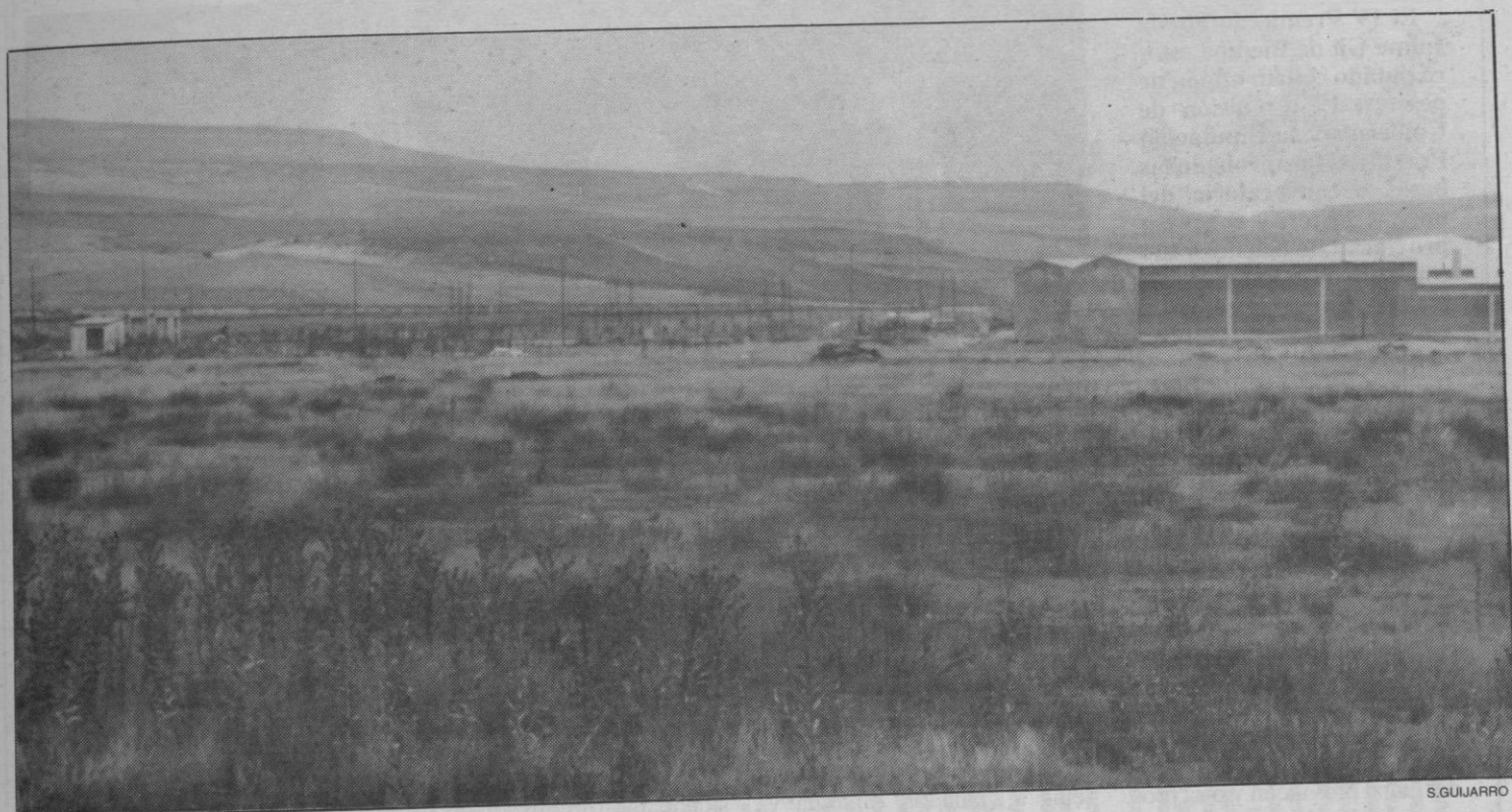
Zona del polígono industrial de Cuéllar por donde se va a realizar la ampliación de terreno.
