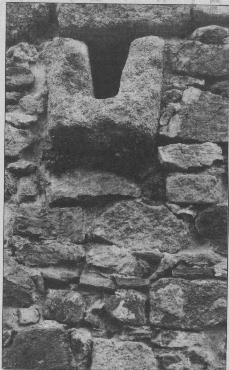
Gárgola en la parte alta del Acueducto.
