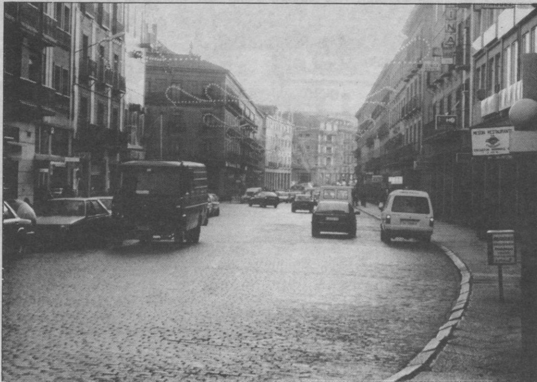
La avenida de Fernández Ladreda albergará el aparcamiento subterráneo con unas 300 plazas.
