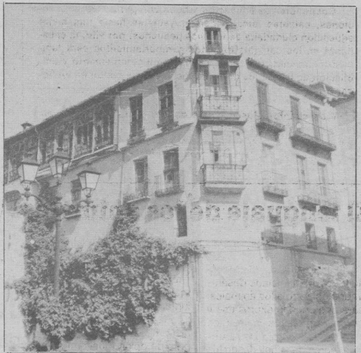
Este es el edificio que será destinado a Centro Artesano
