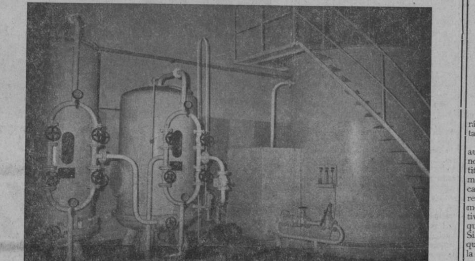
(Un detalle de los circuitos de tratamiento de agua, estación depuradora y filtros de «LA REVOLTOSA» en su planta embotelladora del Polígono industrial en Segovia)
