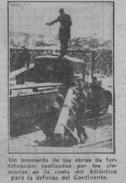
Un momento de las obras de fortificación realizadas por los alemanes en la costa del Atlántico para la defensa del Continente.
