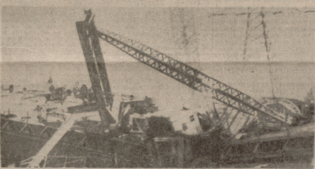
MELBOURNE — Hierros retorcidos y otros destrozos, al derrumbarse parcialmente el puente en construcción de la autopista de Westgate, sobre el río Yarra. Dos horas después del derrumbamiento fueron hallados diecinueve cadáveres entre el barro y los escombros. Se espera haya más víctimas.—(Telefoto Upi-Cifra.)
