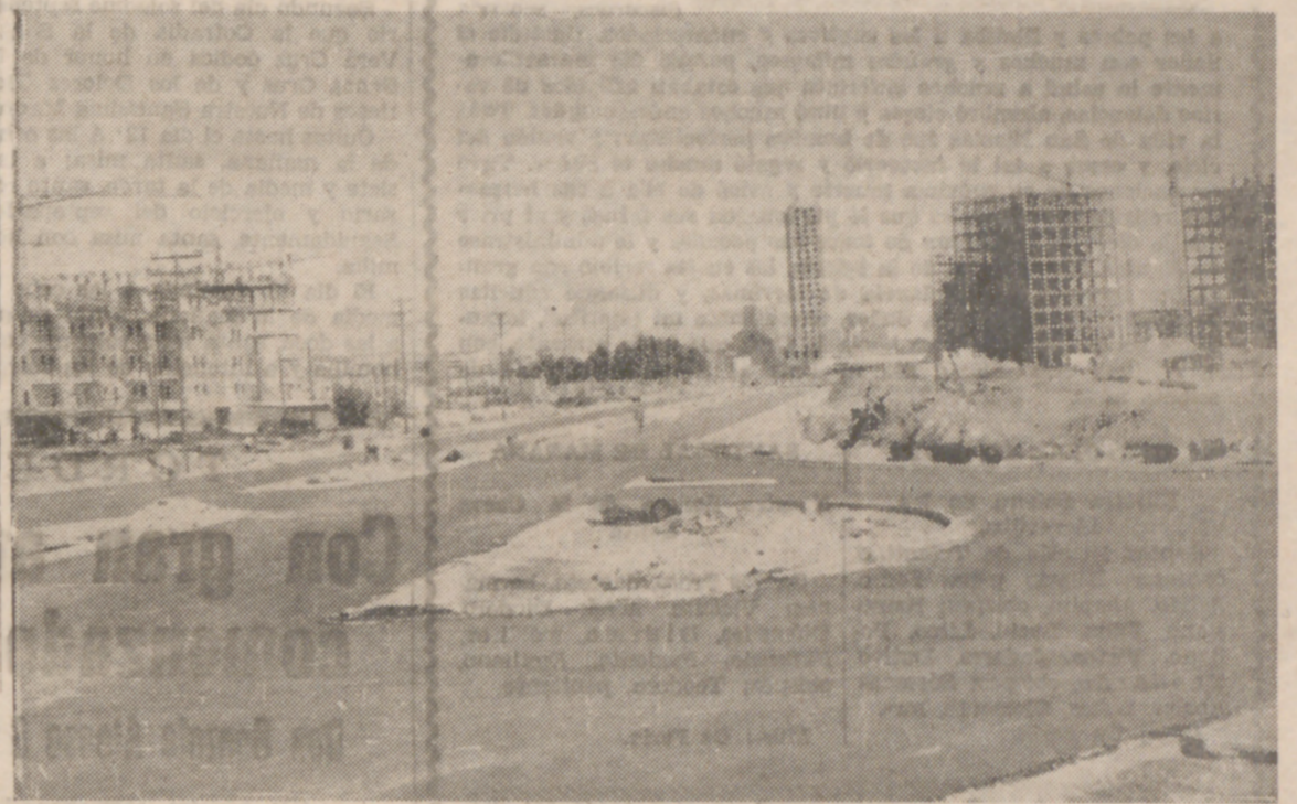
Un aspecto de las obras, que se llevan a gran marcha.
