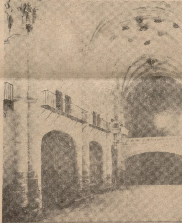
Capilla mayor de San Francisco, vista desde el presbiterio. Al fondo, el coro, sustentado por un buen arco escarzano. A la izquierda se ven los balcones para la familia y cortesanos de los Almirantes de Castilla. En el punto de donde está tomada la fotografía presente hubo en otro tiempo sendos sepulcros del almirante don Luis Enriquez y su mujer doña Victoria Colonna, hoy en el Museo Arqueológico de Palencia.
