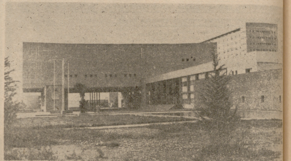
Edificio central de la Universidad Laboral Femenina de Zaragoza. (Foto PYRESA)
