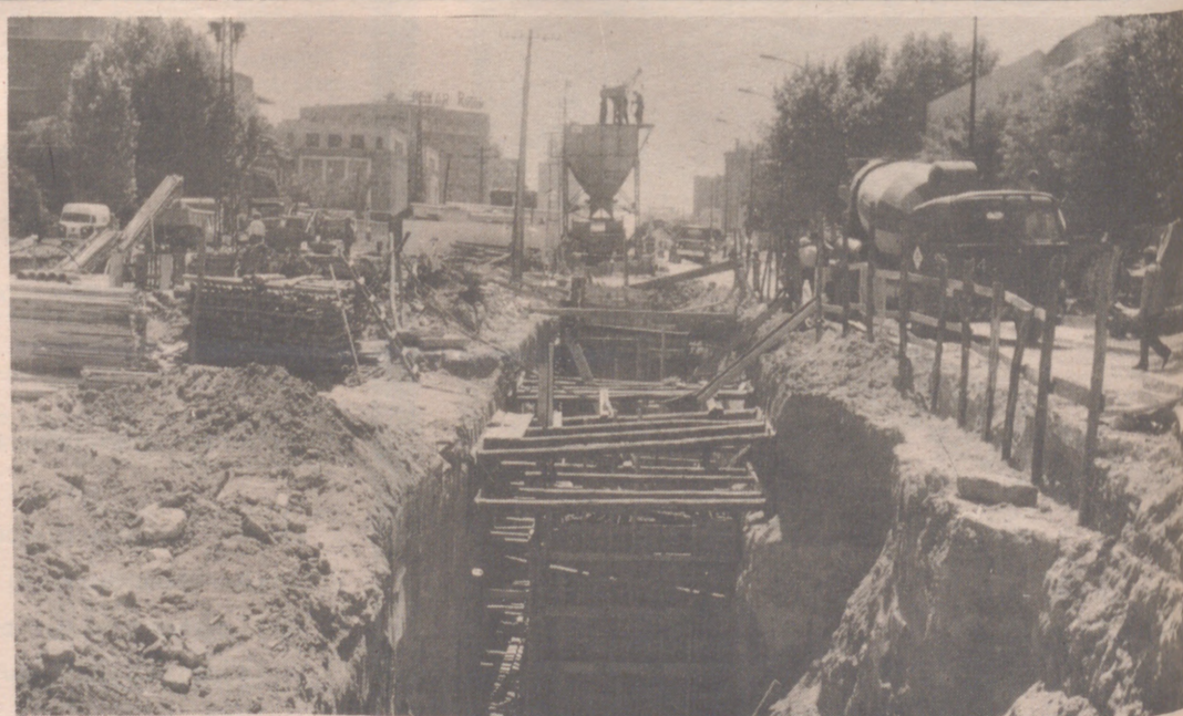
MADRID.- La calle de Joaquín Costa también se ve afectada por las obras del paso subterráneo de la República Argentina, el cual saldrá a la superficie en dicha calle. En la foto se puede apreciar el aspecto que presenta el paseo, durante las obras de construcción. (Foto: Cifra)
