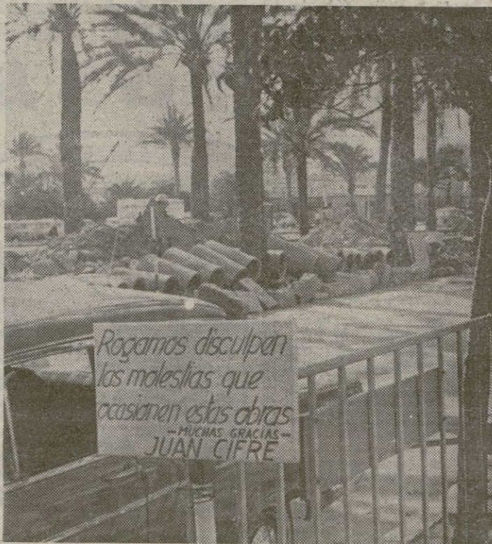
Toda la calzada ha sido levantada. Aquí trabajan máquinas excavadoras, compresores, una flota de camiones, muchos obreros. Estos días el ruido durante toda el día es notable; no queda mas remedio, porque es un paso definitivo para una reforma necesaria. En primer término, un letrero que ruega disculpas por las molestias. Un detalle de buena educación, como se hace en las obras grandiosas que se llevan a cabo por Madrid y otras capitales importantes.
