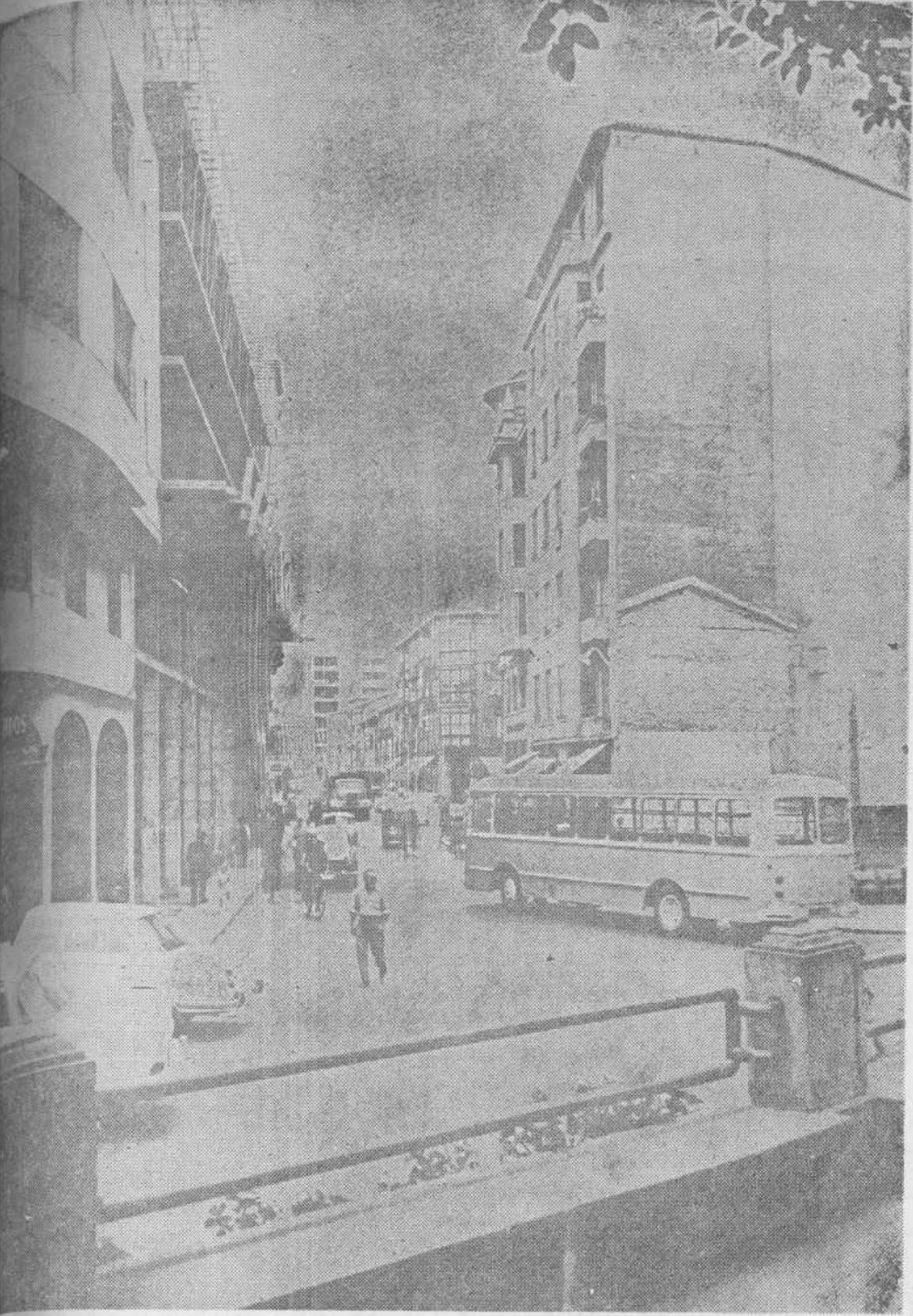
El rápido desarrollo que está experimentando Torrelavega tiene su fiel reflejo en los grandes bloques de viviendas que han transformado la ciudad en pocos años. Aquí la iniciativa particular y el dinamismo de los constructores se traduce en el rápido crecimiento de la población y en la transformación de zonas y terrenos que hasta ahora no podíamos imaginarnos que iban a quedar dentro del casco urbano.
