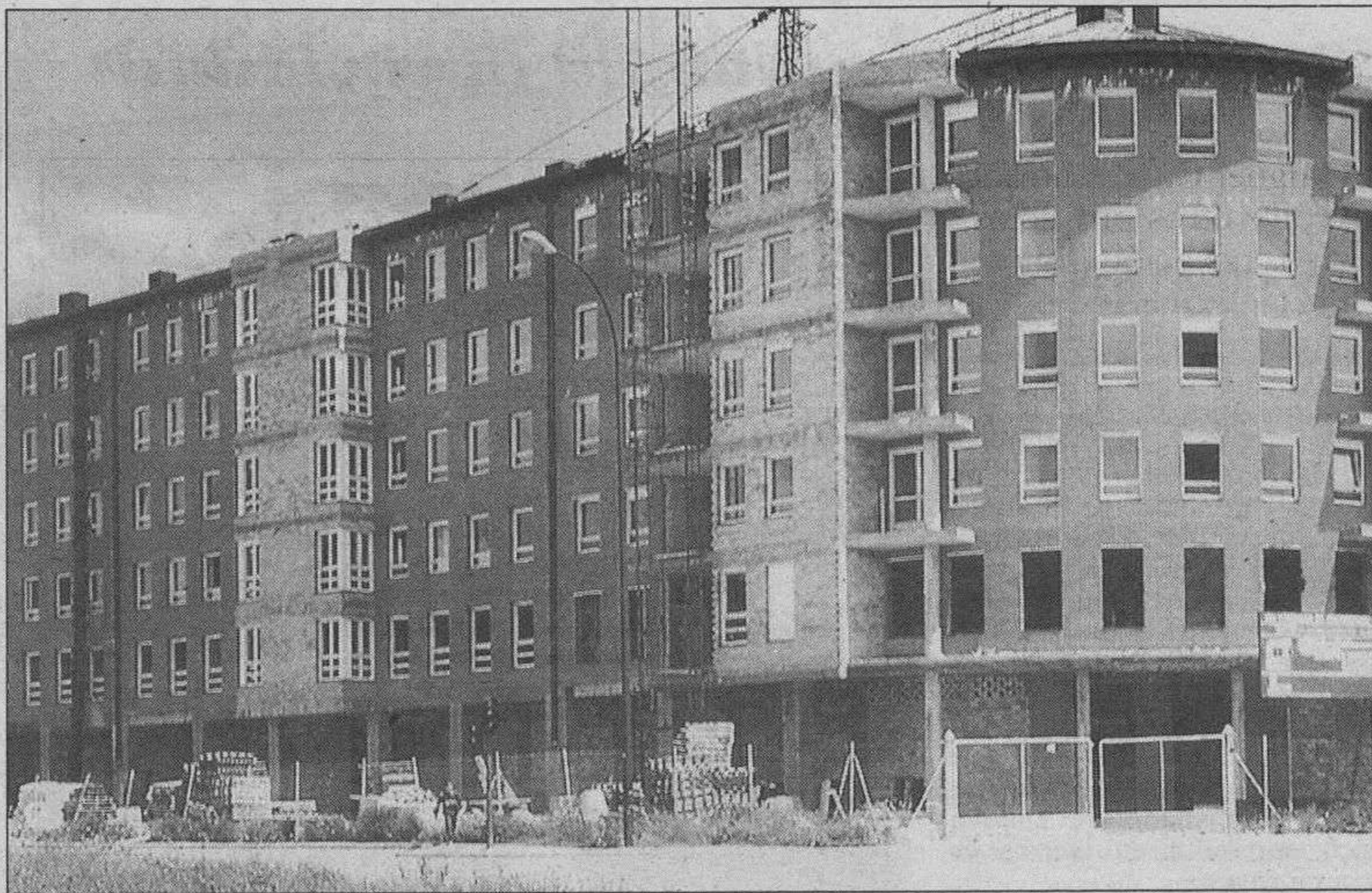
El edificio está situado en la Avenida de Castilla y León entre Carmen Sallés y Obdulio Fernández.
