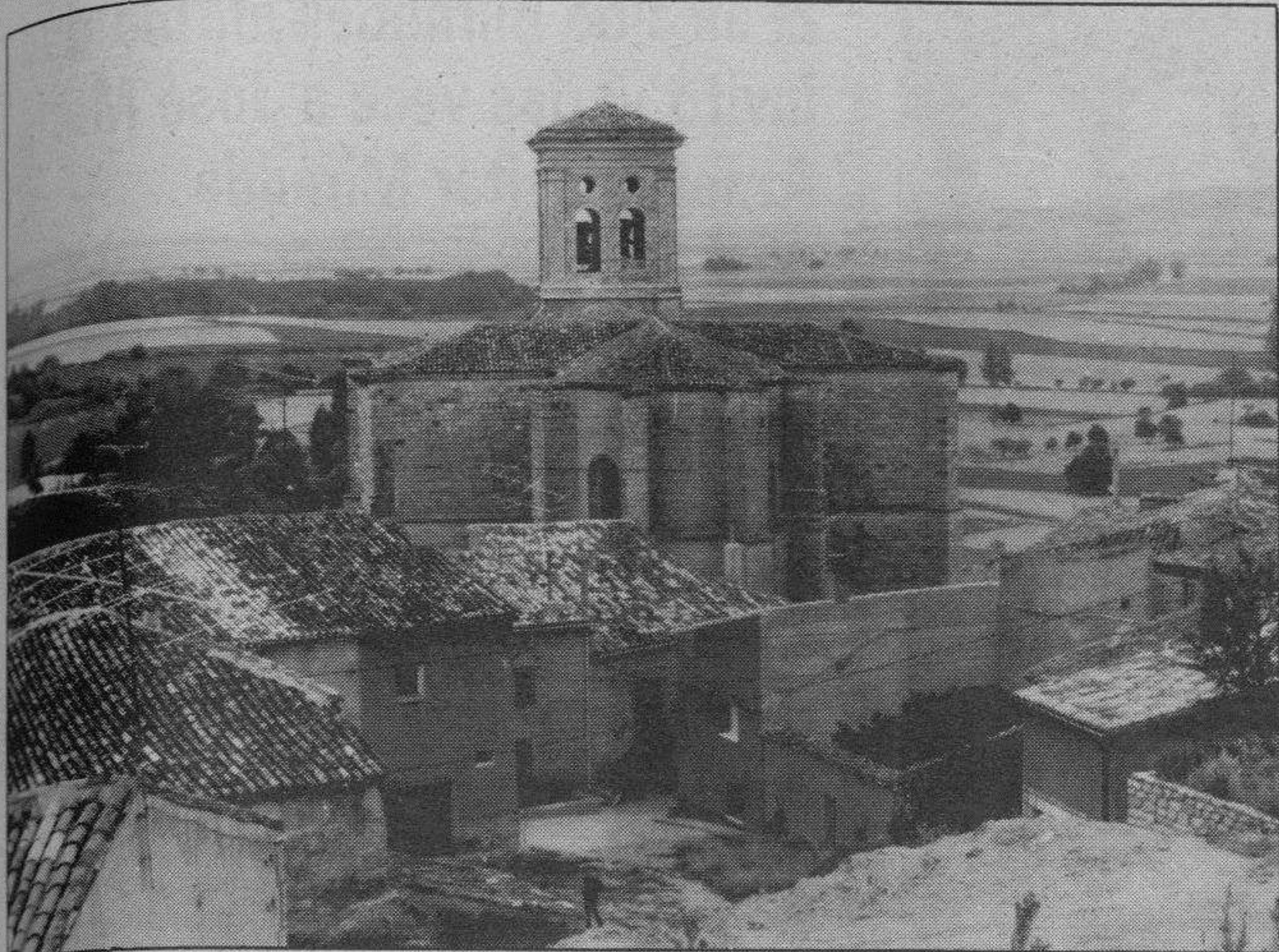
Torre de la iglesia de Pampliega.
