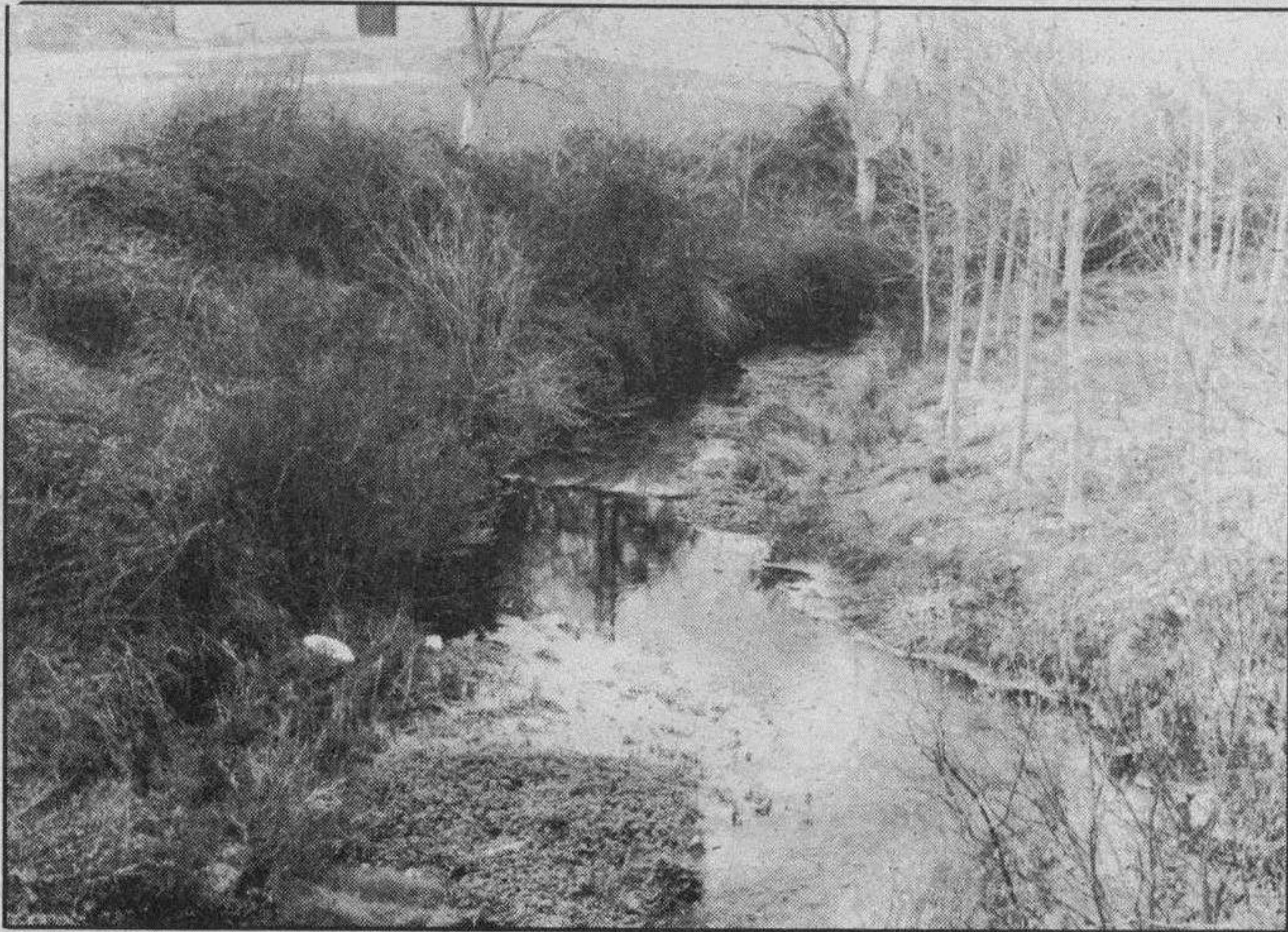
En el transcurso de las próximas semanas comenzarán los trabajos de limpieza y drenaje del río Oroncillo. Se pretende con ello eliminar los problemas que se originan en su cuenca tras fuertes lluvias.
