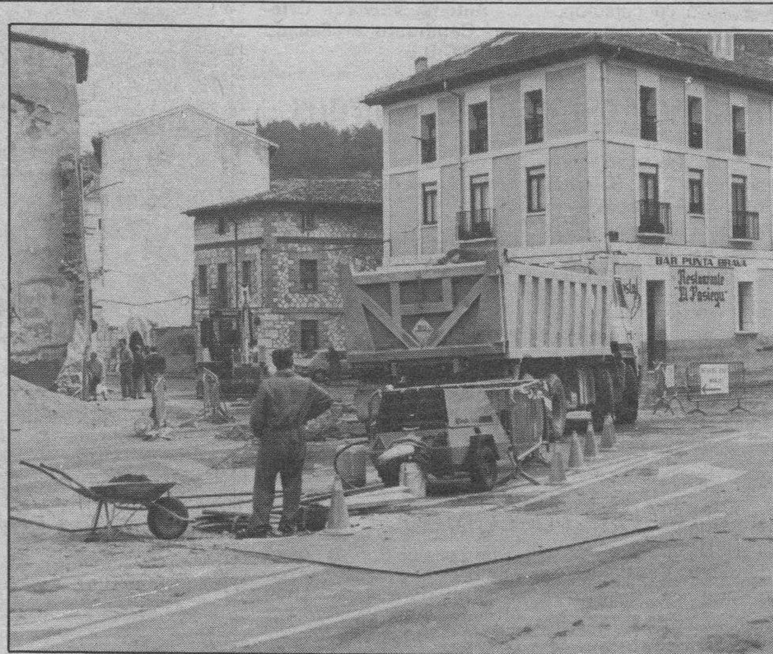
Obras en la calle Villalón.— A primeras horas de la mañana de ayer, el Servicio Municipal de Aguas del Ayuntamiento inició obras en las redes de distribución de agua y alcantarillado de la calle Villalón. Con ellas quedarán completamente renovados los sistemas de conducción. El plazo de las obras es, según las previsiones, de dos meses, al cabo de los cuales se habrá incrementado la capacidad de la red y creado una infraestructura adecuada para la calle. Durante el tiempo de su ejecución, la vía estará cerrada al tráfico de vehículos. El cierre y el desvío de la circulación por calles adyacentes han sido señalizados por el Servicio de Aguas del Ayuntamiento, que ha colocado vallas en los extremos de la calle, entre la de Emperador y el paseo de la Isla.
