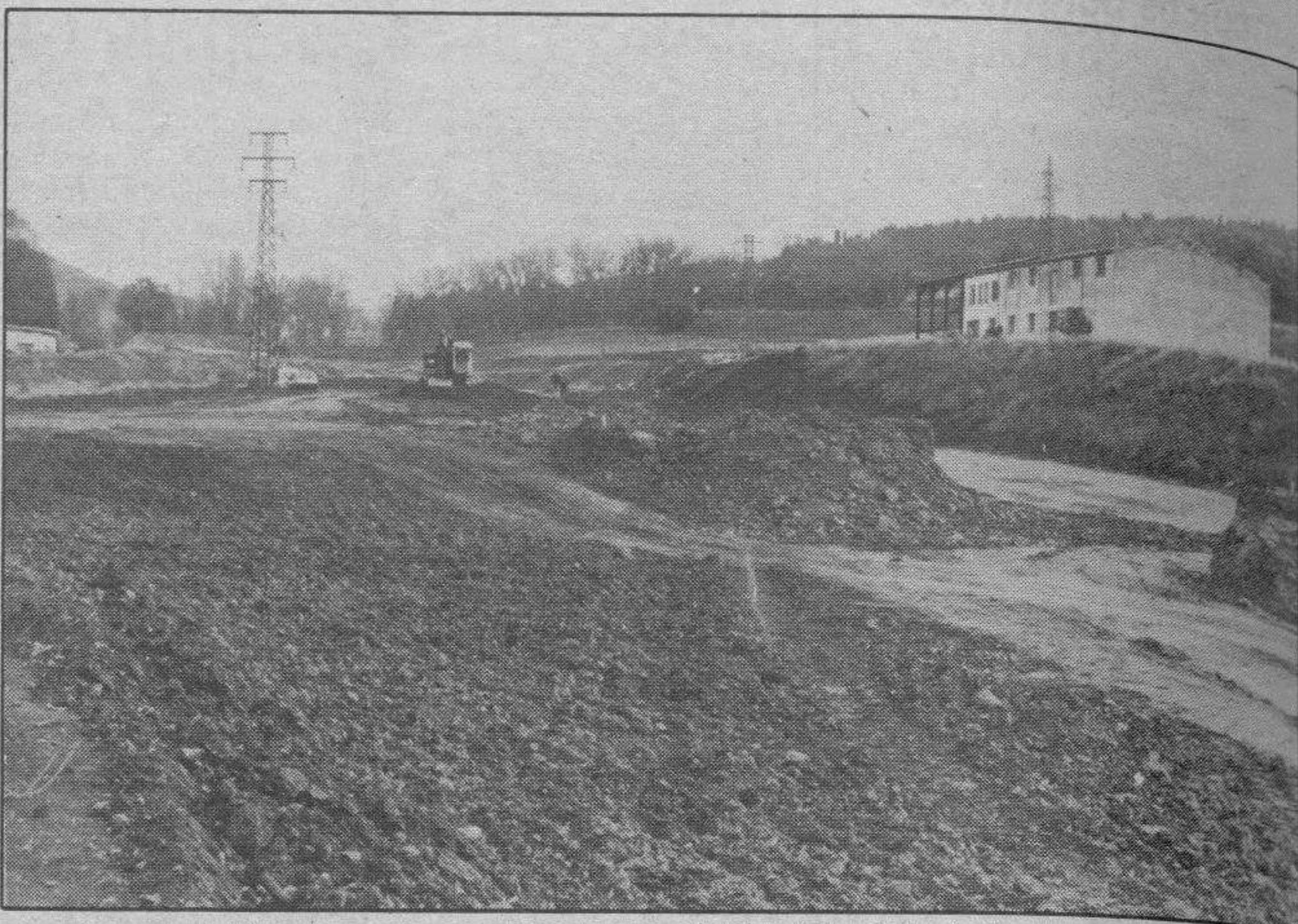
Las excavadoras ya han comenzado el trabajo en la vía Norte.
